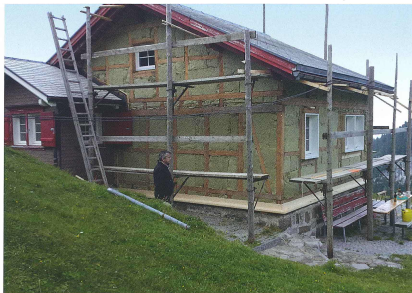
Mit Matten aus Steinwolle wurde das gesamte Haus neu isoliert.
