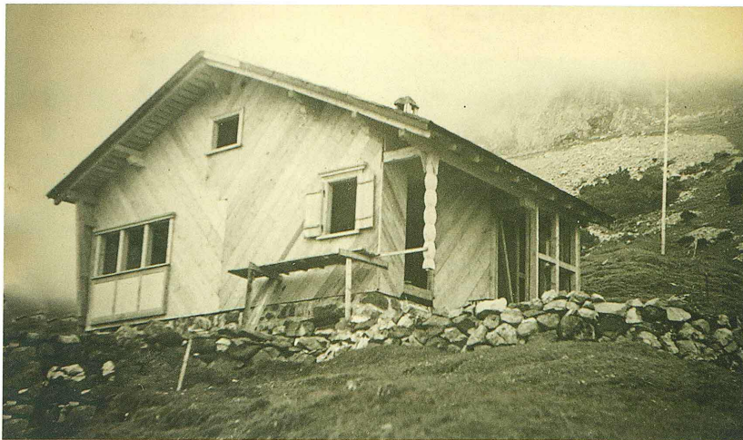
Bereits nach vier Monaten Bauzeit stand der Rohbau!
