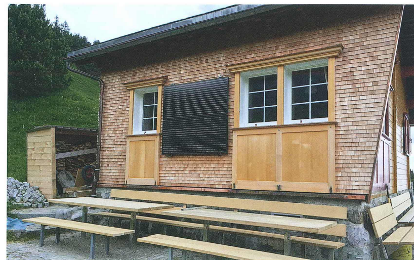
Eine Fassade aus Lärchenschindeln, wunderschöne Aufzugläden und eine neue Solaranlage prägen die Aussenhülle des Gartehüsli. Ebenso wurde eine neue «Gartenmöblierung» erstellt.
